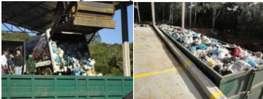
Figura 2 – Estação de transbordo
