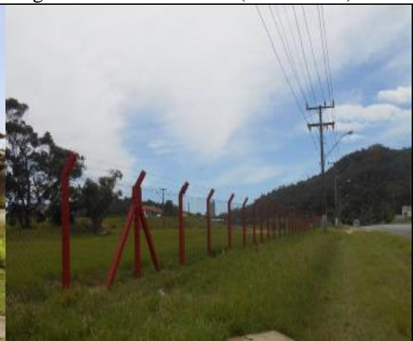
Figura 19 Imbituba – SC (cercamento)
