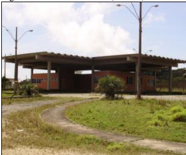
Figura 18 – Imbituba – SC (aduana)
