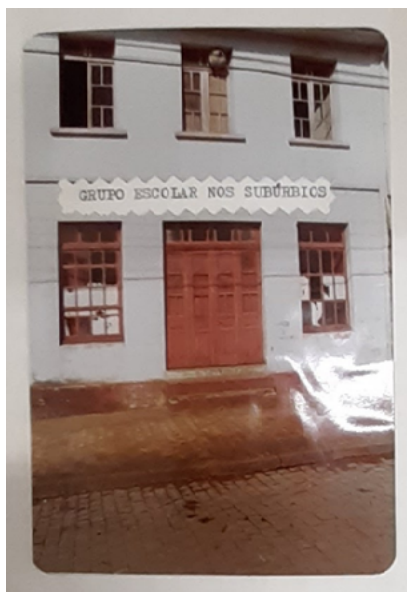
Figura 3 – Frente do prédio Armazém Curra – Grupo Escolar.
