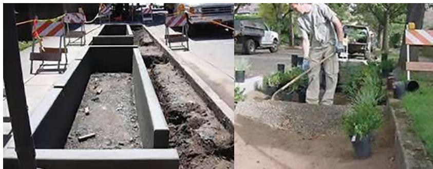
Fotos 5 e 6 – Vantagens na execução do Jardim de chuva
