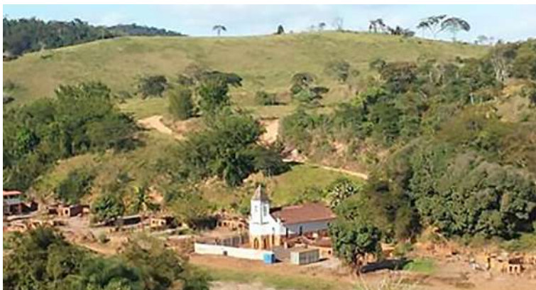
Figura 2 – As ruínas de Gesteira Velho, após o rompimento de Fundão
