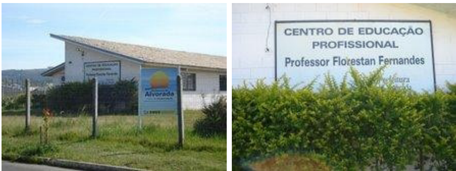
Figura 14 – Imagens da estrutura física externa do Polo
