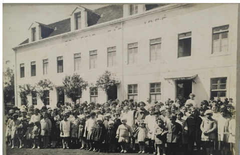
Figura 2 – Fachada da Escola Normal São José (1930)
