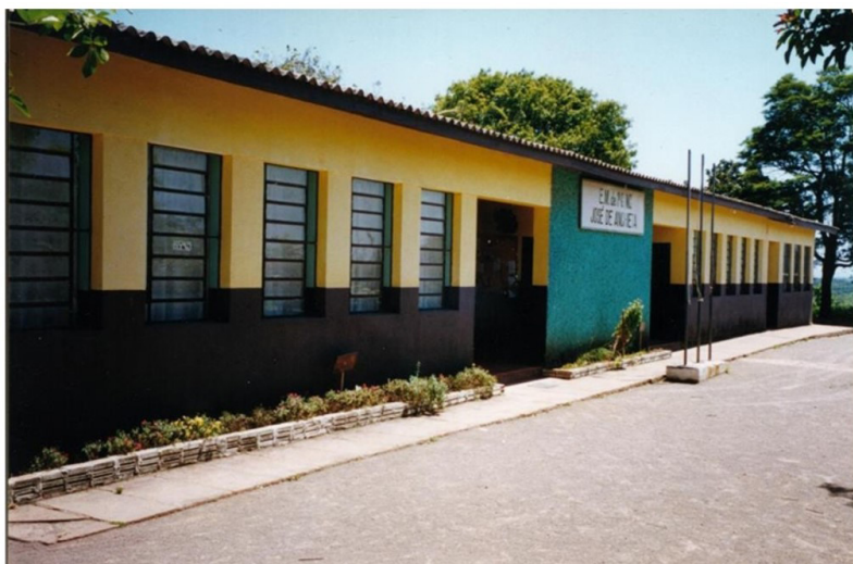
Figura 3 – Visão frontal do prédio da Escola, em 1984
