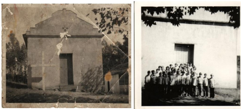
Figura 3 – Fotos da capela onde funcionava a escola
