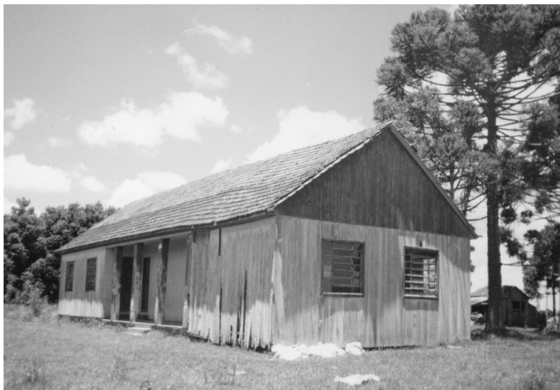
Figura 3 – Estrutura em madeira que abrigou a Escola Rural São Jorge
