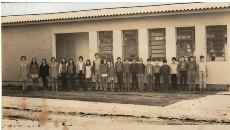
Figura 2 – Prédio da escola em 1973
