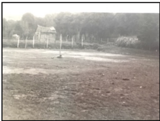
Figura 2 – Fundos do prédio do Grupo Escolar Jansen (1958)
