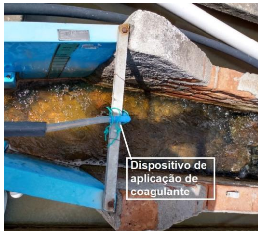
Figura 2 – Mistura rápida calha Parshall
