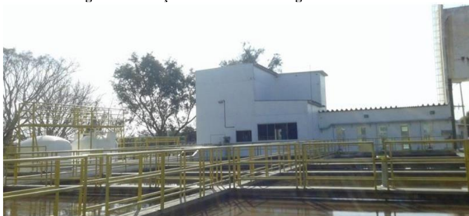
Figura 1 – Estação de tratamento de água de São Gabriel
