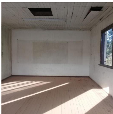
Figura 13 – Sala de aula 2, andar superior
