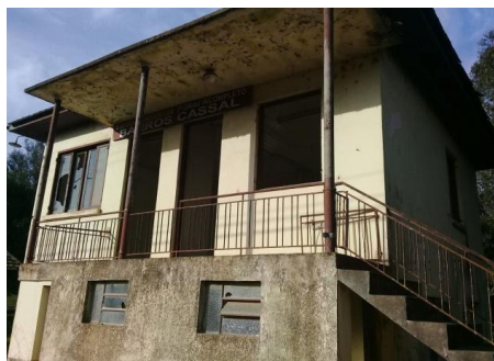
Figura 11 – Lateral do antigo prédio da escola.
