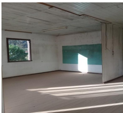
Figura 12 – Sala de aula 1, andar superior
