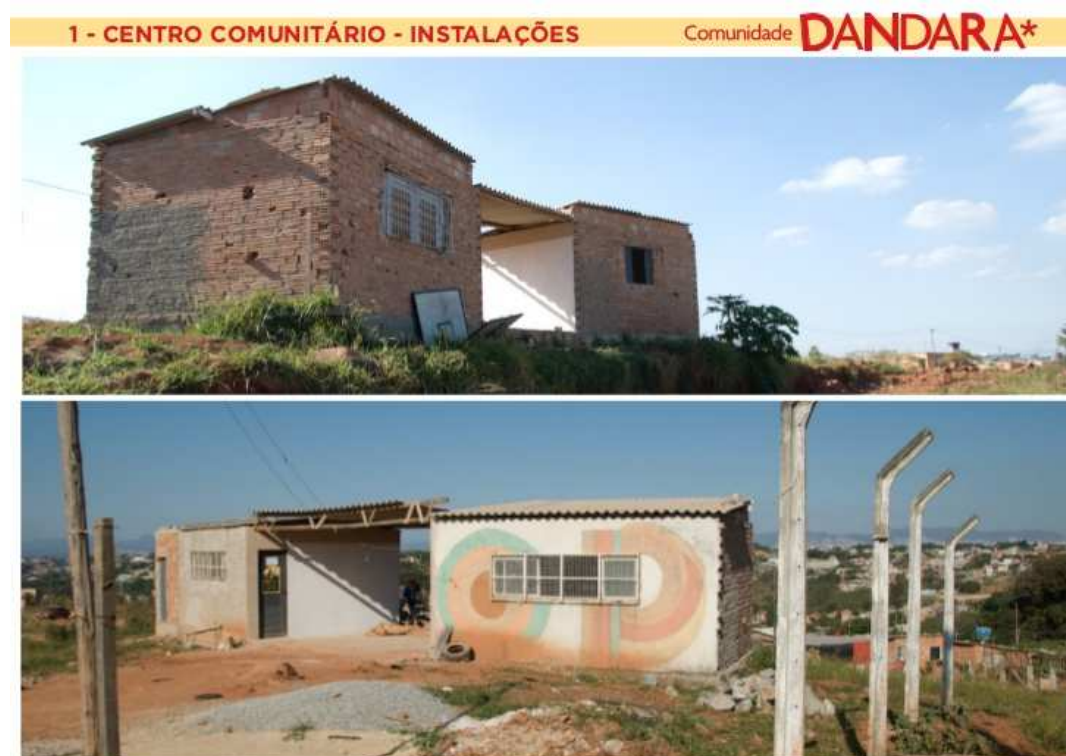
Figura 4 – Centro Comunitário Prof. Fábio Alves, na ocupação Dandara (em construção)
