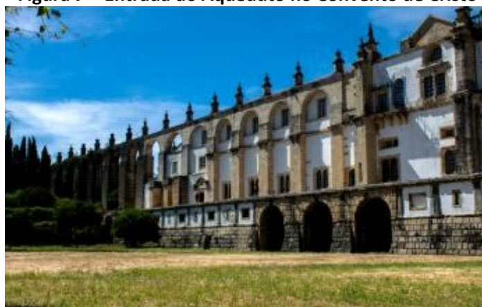
Figura 7 – Entrada do Aqueduto no Convento de Cristo
