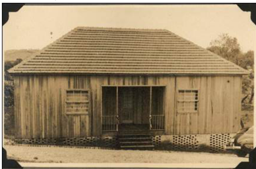
Fotografia 20 – Edifício do G.E.M. Padre Antônio Vieira
